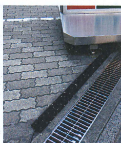
外看板のケーブル保護
