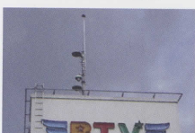
BTV株式会社IT産業ビル屋上(宮崎)
