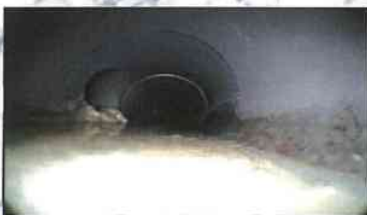
配管内の確認
